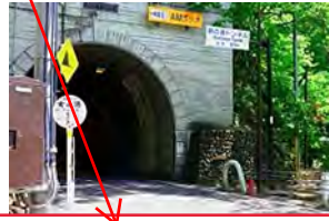
DSCF1541_目の湯トンネル.jpg
